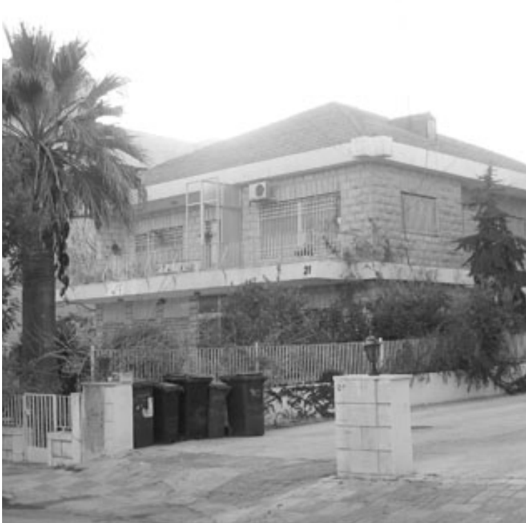
المبنى الجديد في منطقة الشيمسياني
